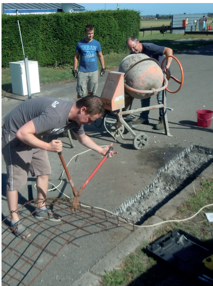
Dichten inzakking asfalt door Guy, Jens en Dieter
