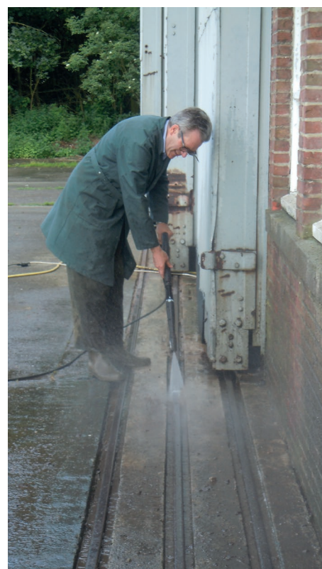
Andre bij het uitspuiten van de rails loods zuid
