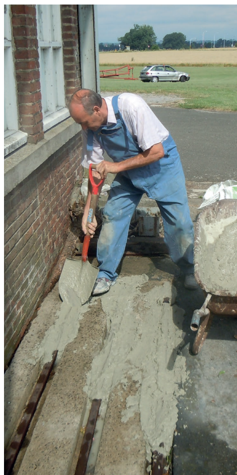
Çoike bij het inbetoneren van de rails
